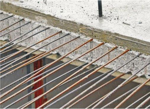
هو الفاصل الناتج عن صبتين متجاورتين للخرسانة، ويتوجب عمله بسبب عدم الصب بعملية مستمرة ومضي فترة زمنية بين عملية الصب. ويجب عمل فاصل الصب للخرسانة في أماكن القصر الأقل ( Minimum Shear ) سواء كان ذلك للبلاطات أو الجسور أو الارضيات....
